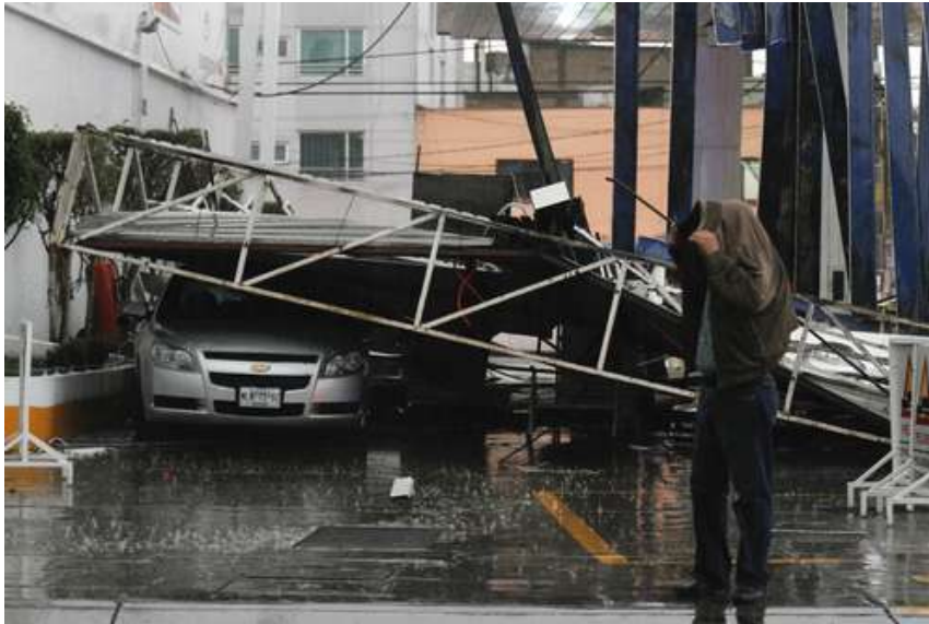
Foto 5: El techo de una gasolinera cayó sobre los autos que esperaban atención, en avenida Politécnico y Poniente 112
